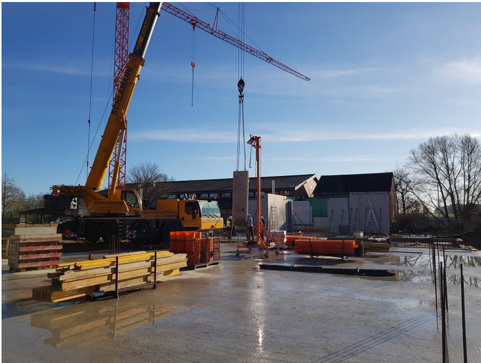
Bild Nr.: 1 | Datum: 16.01.2020 | Montage der Beton- Wandelemente im Erdgeschoss
