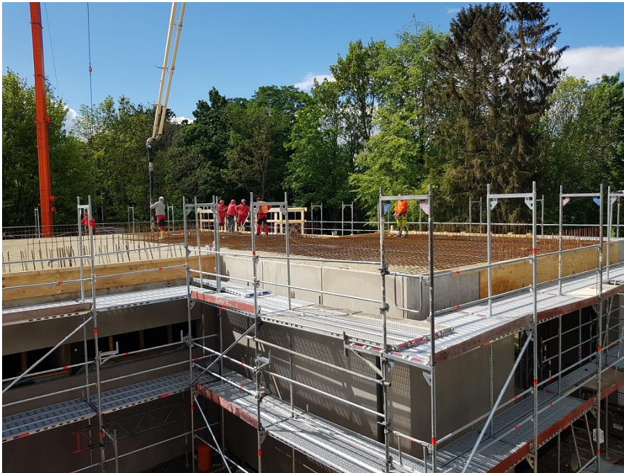
Bild Nr.: 8 | Datum: 05.05.2020 | Betonage der Stahlbetondecke über dem Erdgeschoss
