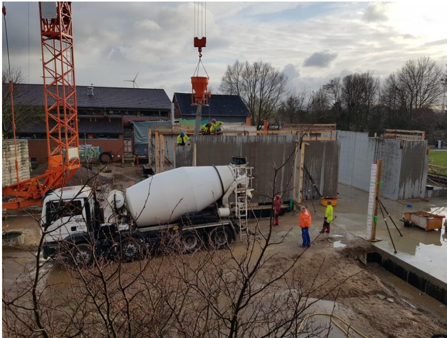
Bild Nr.: 2 | Datum: 04.02.2020 | die montierten Wandelemente werden ausbetoniert
