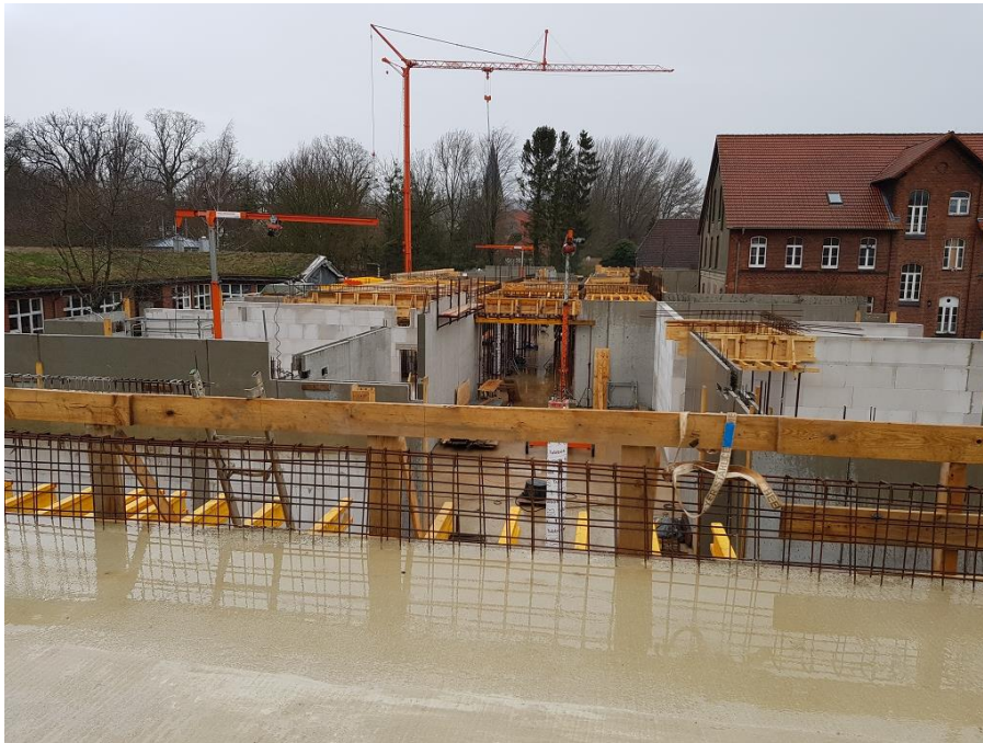
Bild Nr.: 4 | Datum: 10.03.2020 | Schal- und Bewehrungsarbeiten für die Stahlbetonunterzüge
