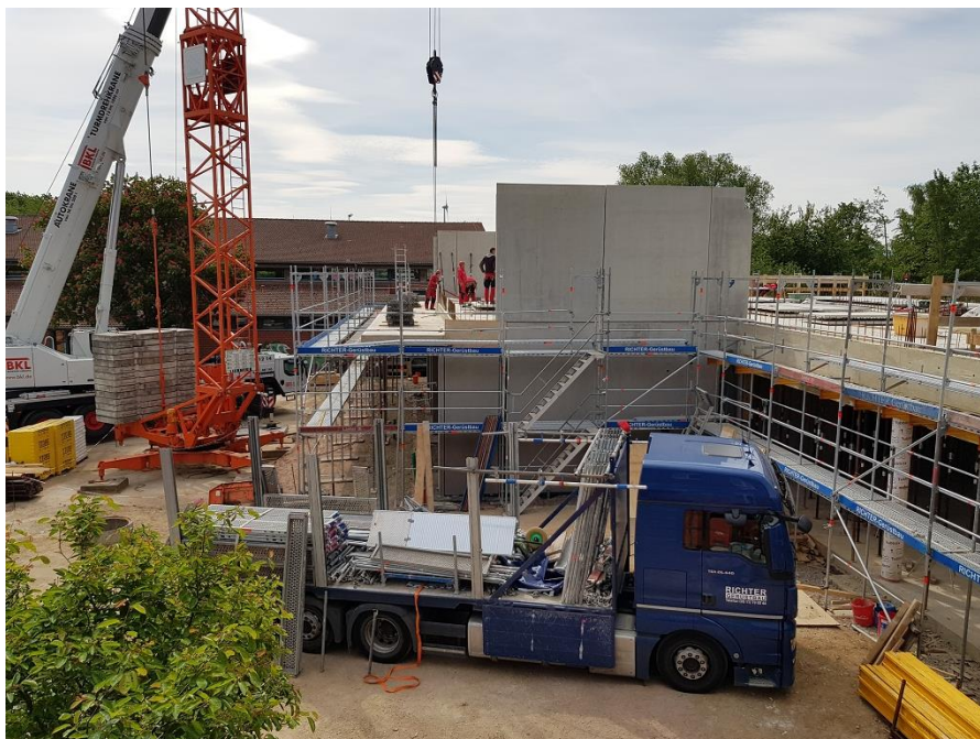
Bild Nr.: 9 | Datum: 18.05.2020 | ergänzende Gerüstarbeiten und Montage der Beton- Wandelemente im Obergeschoss
