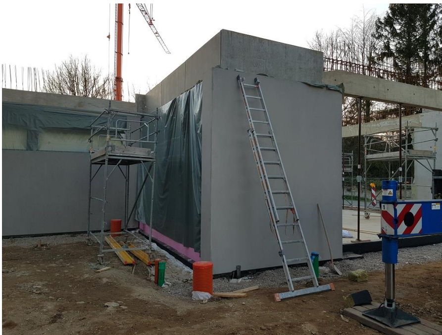
Bild Nr.: 7 | Datum: 23.03.2020 | Montage der äußeren Fassade aus Sichtbetonfertigteilen
