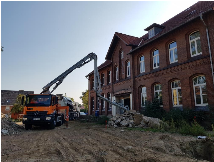
Bild Nr.: 12 | Datum: 11.09.2019 | Auffüllen des alten Kellers im Altbau mit Flüssigboden
