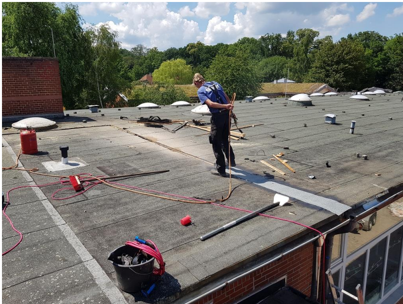
Bild Nr.: 5 | Datum: 17.06.2019 | Gebäudetrennung als vorbereitende Maßnahme für die Abbrucharbeiten
