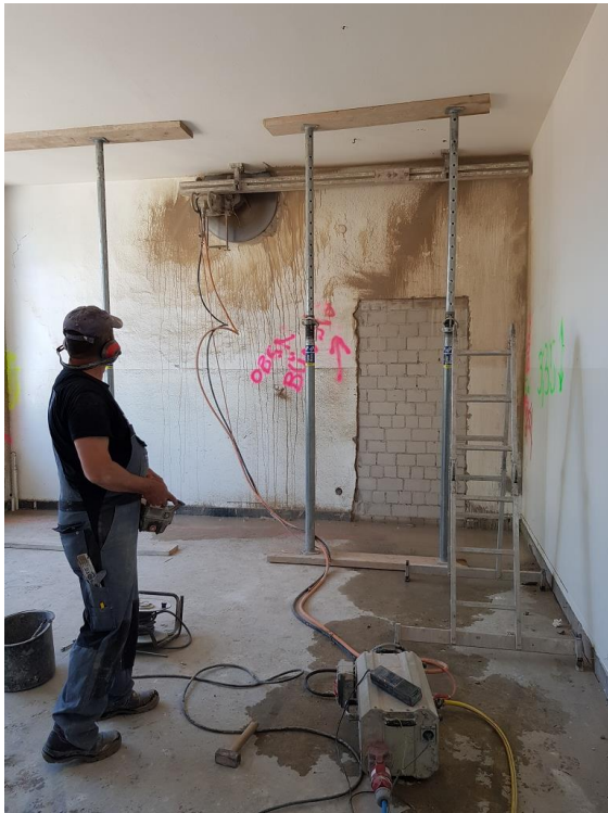
Bild Nr.: 4 | Datum: 17.06.2019 | Gebäudetrennung als vorbereitende Maßnahme für die Abbrucharbeiten
