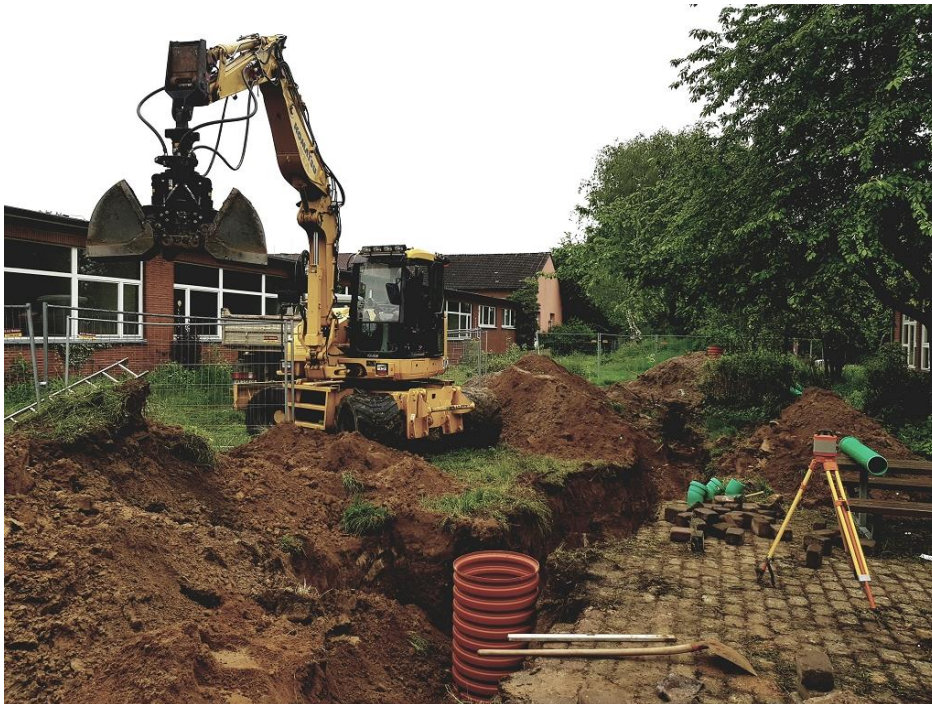
Bild Nr.: 1 | Datum: 22.05.2019 | Umschlussarbeiten zur Stilllegung der Zisterne der Peter- Härtling- Schule
