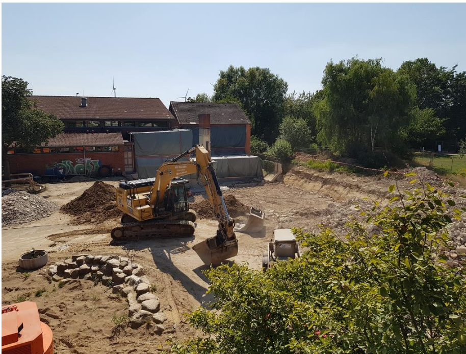
Bild Nr.: 11 | Datum: 23.08.2019 | Erdarbeiten und Auffüllung der Baugrube, die durch den Abriss des Kellers entstanden war
