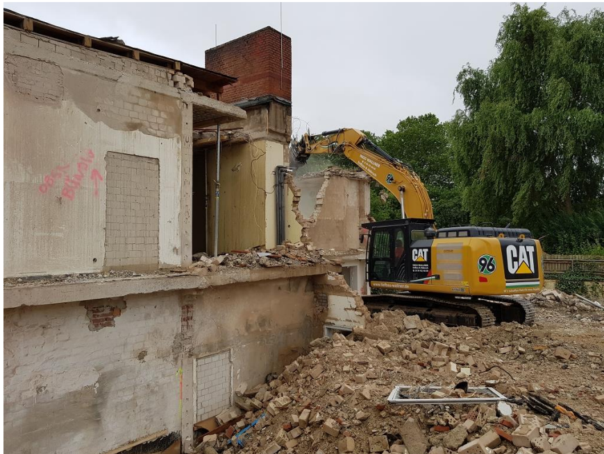
Bild Nr.: 8 | Datum: 15.07.2019 | Abbrucharbeiten im Bereich der alten Umkleiden mit Ansicht der erfolgten Gebäudetrennung
