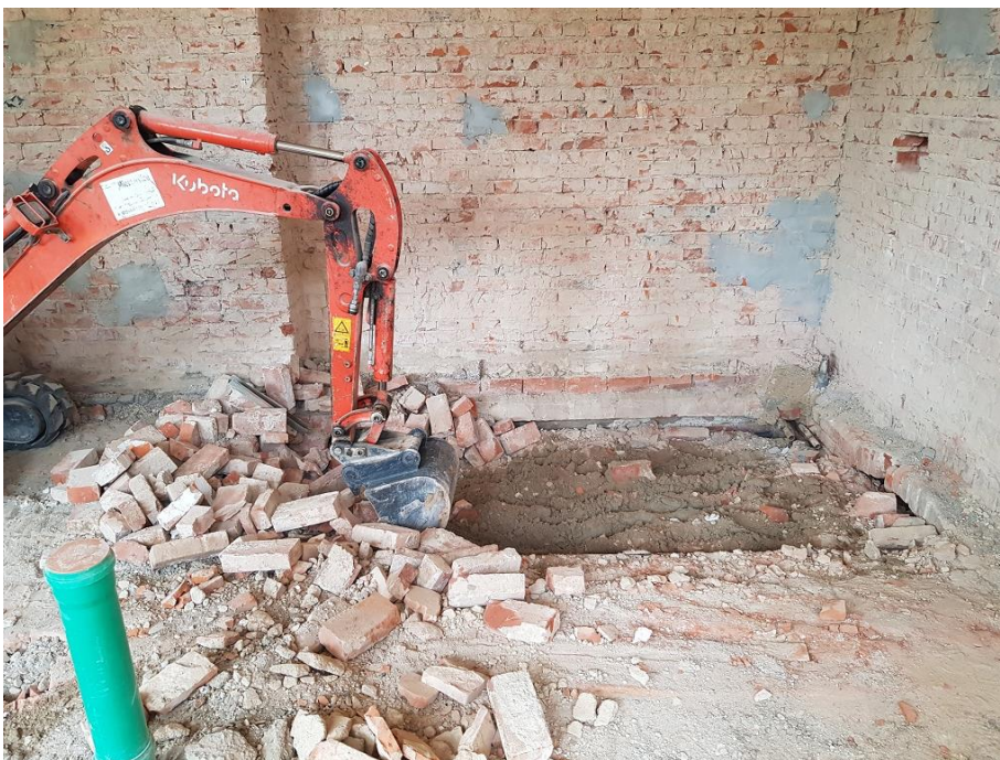
Bild Nr.: 13 | Datum: 18.09.2019 | Abbruch der alten Kellerdecke im Altbau
