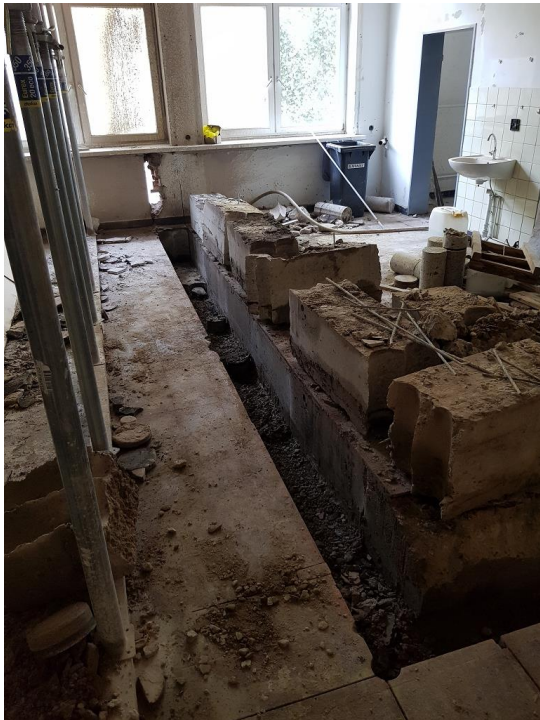
Bild Nr.: 6 | Datum: 26.06.2019 | Gebäudetrennung und Einbau einer Drainage im Keller des alten Grundschulgebäudes als vorbereitende Maßnahme für die Abbrucharbeiten
