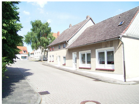
Hinter der Post – vorher
