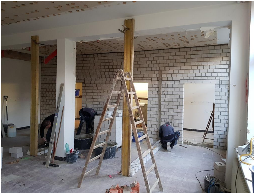
Bild Nr.: 1 | Datum: 14.01.2019 | Vorabmaßnahmen im Technikeller: Mauerarbeiten zur statischen Unterstützung der Kellerdecke
