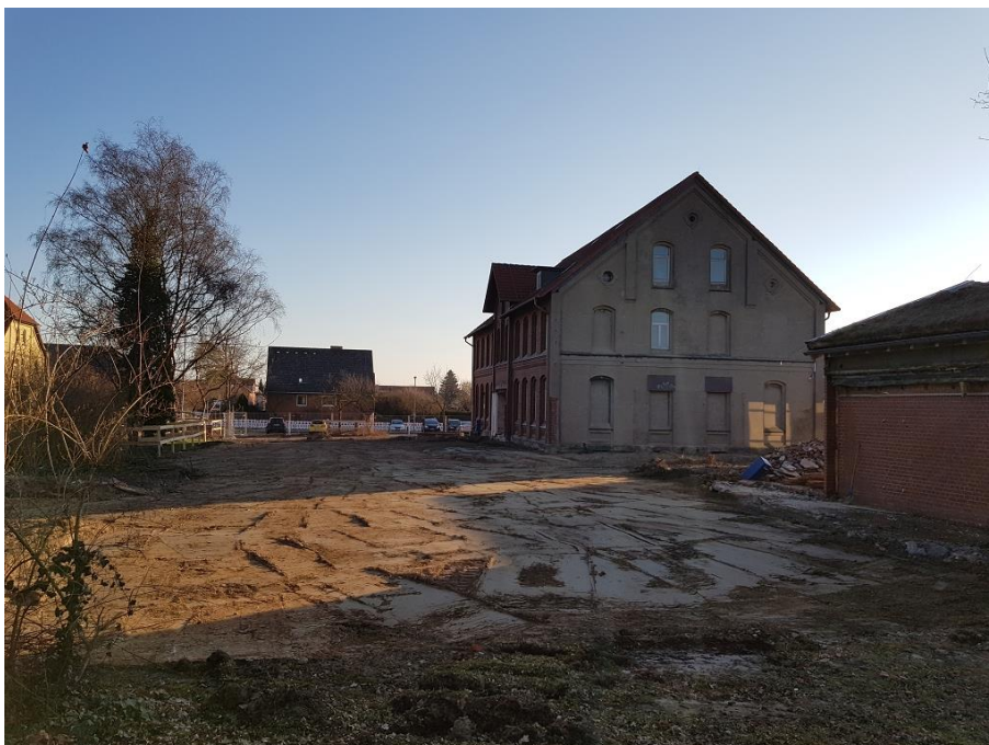
Bild Nr.: 9 | Datum: 18.02.2019 | der Teilabbruch ist abgeschlossen und der Abbruchbereich beräumt
