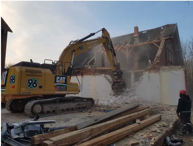
Bild Nr.: 4 | Datum: 24.01.2019 | Abbrucharbeiten am Altbau der Peter- Härtling- Schule
