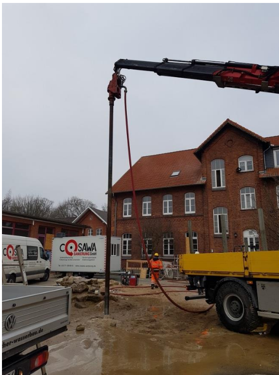
Bild Nr.: 5 | Datum: 24.01.2019 | Bohrarbeiten für die Grundwassermessstelle
