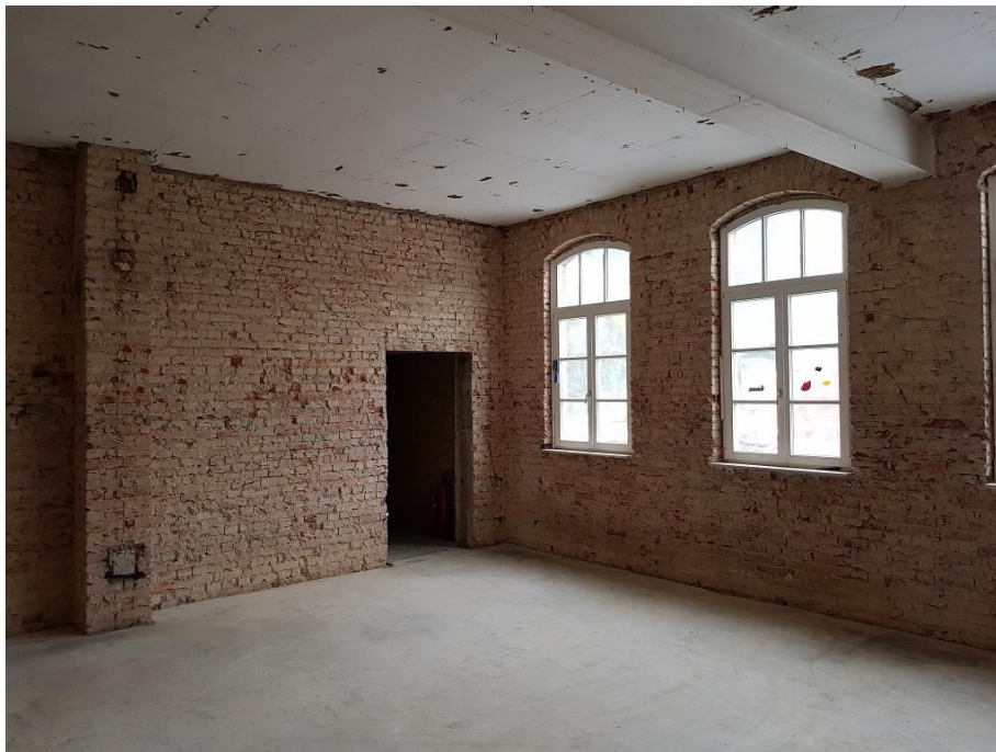
Bild Nr.: 8 | Datum: 01.02.2019 | die Schadstoffsanierung und Entkernung des Altbaus ist mittlerweile abgeschlossen worden
