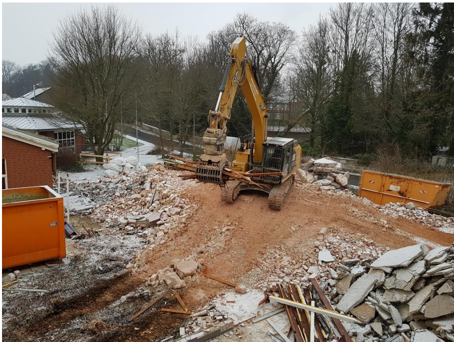
Bild Nr.: 7 | Datum: 01.02.2019 | die abgebrochenen Baustoffe werden sortiert
