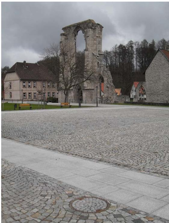
von Flächen unterbleiben muss. Durch einen Wechsel von Pflasterformaten, Pflasterverbänden und auch durch den Wechsel von Pflaster zu Plattenbelägen (vorzugsweise im Bereich der Wege) können unterschiedliche Bereiche diskret differenziert werden, ohne dass die Grundsprache – das Material - gewechselt werden muss. Allerdings verdeutlicht dies auch, dass die Materialwahl sehr sorgfältig erfolgen muss, um eine derartige Vielfalt zu ermöglichen.
