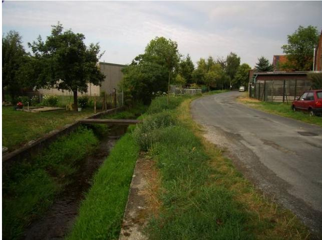
Bei einer mittleren Breite des Straßenraumes von etwa 9 Metern und zusätzlich einer Breite der Gewässerparzelle von 4 m weist die Straße eine Befestigung von ca. 4,75 m Breite auf, die vor einigen Jahren mittels eines Polymer-Anspritzverfahrens aufgebracht wurde. Ein separater Gehweg besteht nicht; der östliche Teil der Straße wird jedoch nur sporadisch befahren und hat eine verminderte Breite bis zu 3 Metern. Die Durchfahrt zur Wallstraße ist
