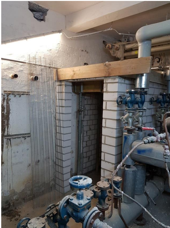
Bild Nr.: 2 | Datum: 29.08.2018 | Vorabmaßnahmen im Technikkeller: Herstellen von neuen Hausanschlussräumen
