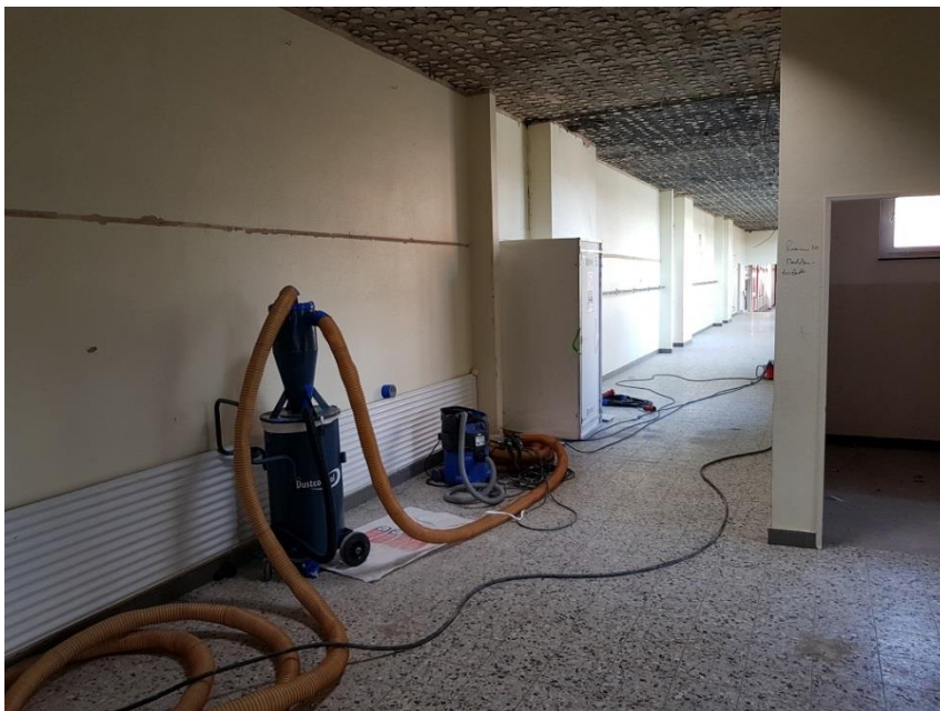
Bild Nr.: 13 | Datum: 05.12.2018 | Schleuse für Schadstoffsanierung im Anbau
