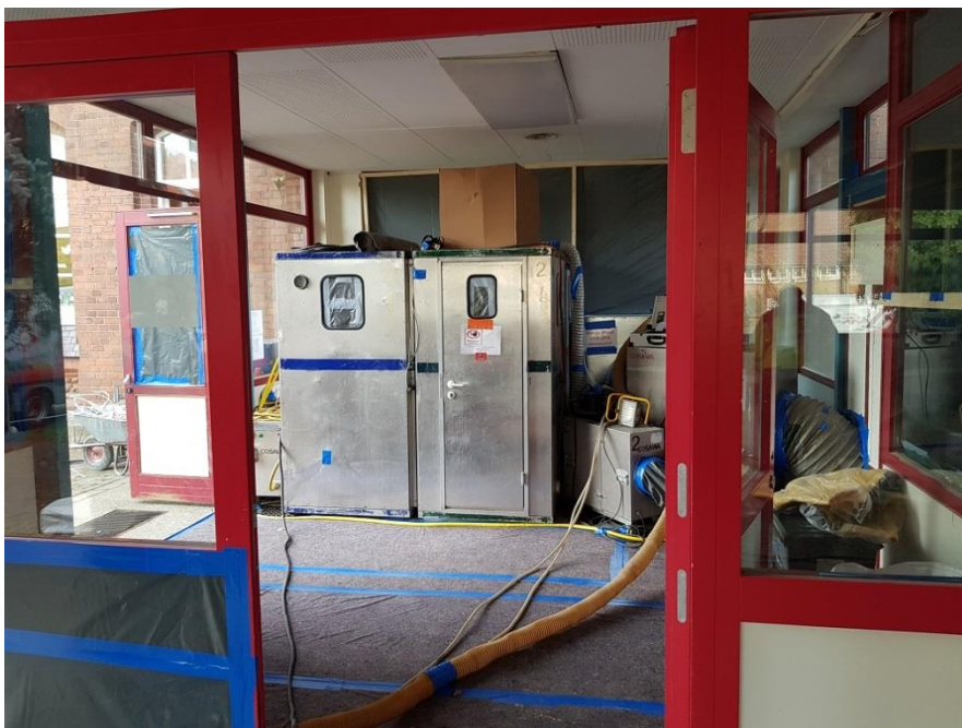
Bild Nr.: 9 | Datum: 06.11.2018 | Aufbau der 4- Kammer Schleuse für die Schadstoffsanierung im Treppenhaus Altbau
