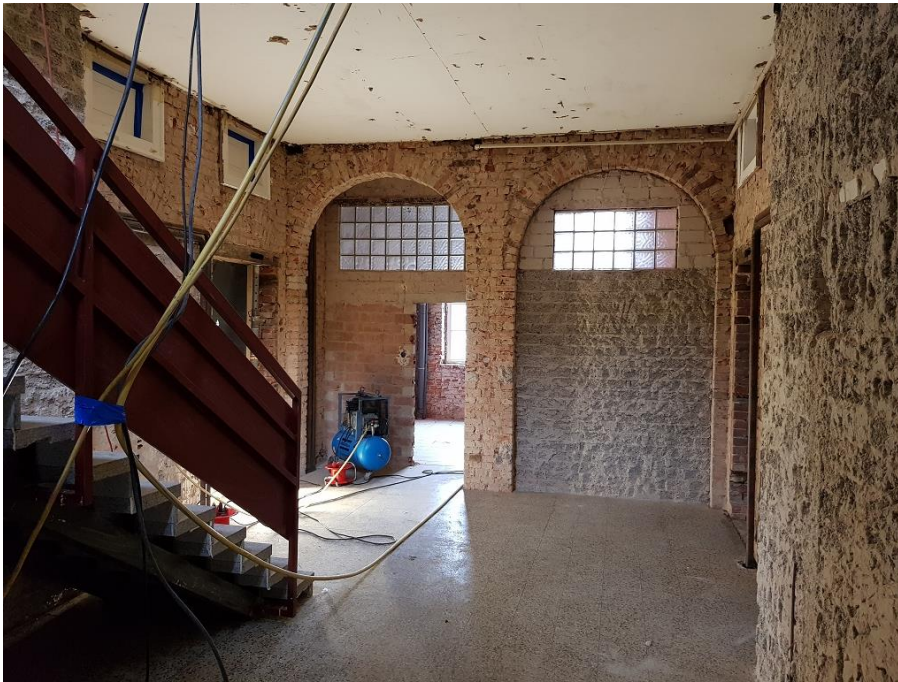
Bild Nr.: 10 | Datum: 30.11.2018 | Entkerntes und schadstoffsaniertes Treppenhaus im Altbau
