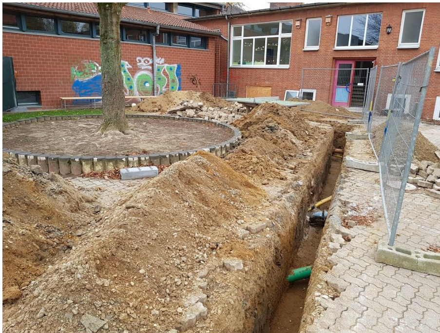
Bild Nr.: 8 | Datum: 05.11.2018 | Anschlussarbeiten der Gas- und Wasserleitungen
