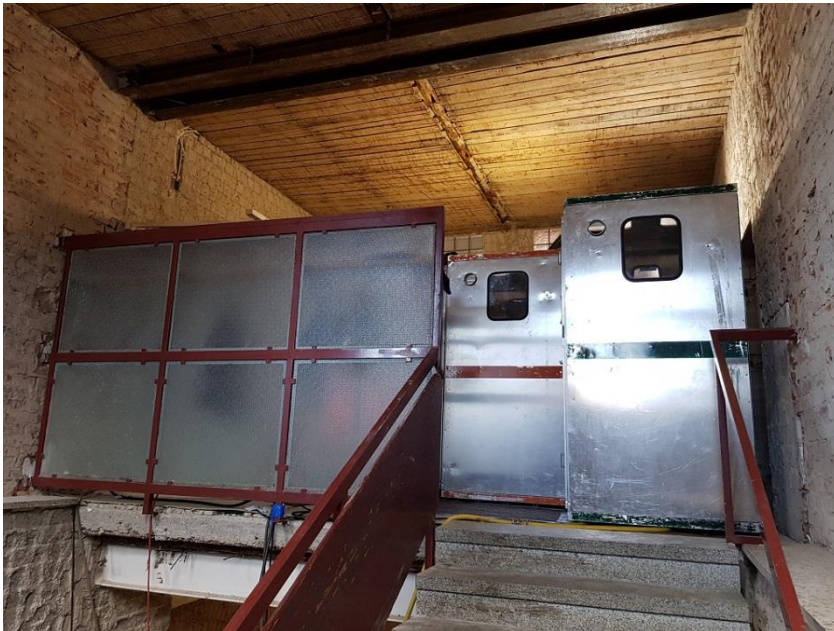
Bild Nr.: 12 | Datum: 03.12.2018 | 4- Kammerschleuse für die Schadstoffsanierung der oberen Klassenräume im Altbau
