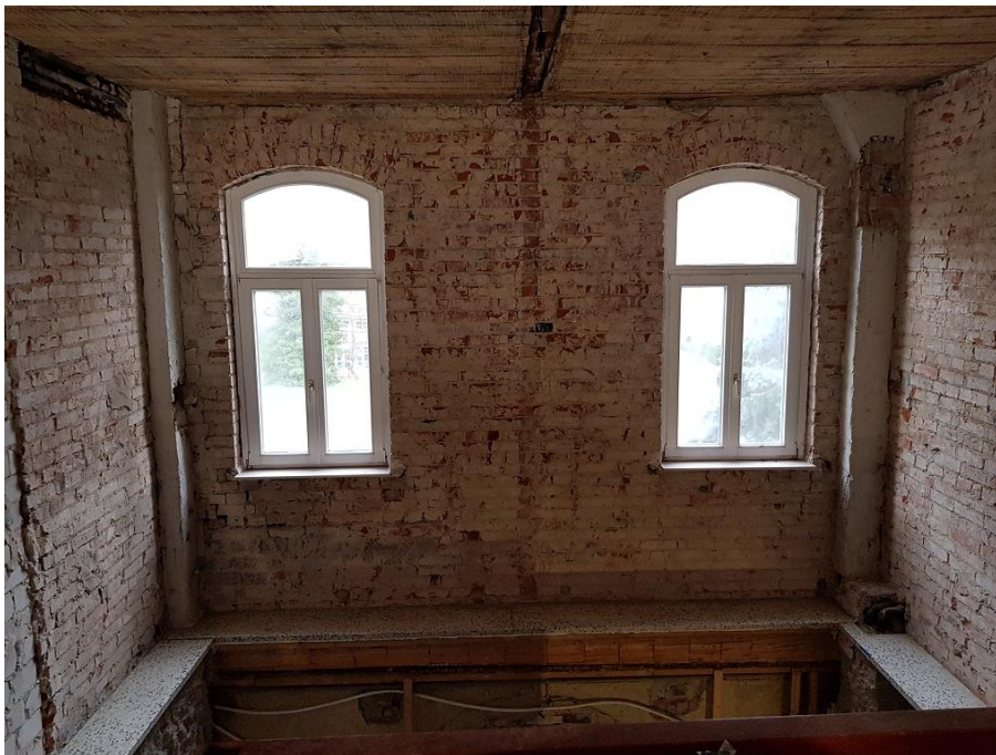
Bild Nr.: 11 | Datum: 30.11.2018 | Entkerntes und schadstoffsaniertes Treppenhaus im Altbau
