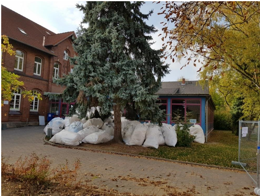
Bild Nr.: 5 | Datum: 18.10.2018 | Lagerung von ausgebauter Dämmung (KMF)
