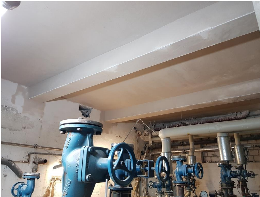
Bild Nr.: 1 | Datum: 20.08.2018 | Vorabmaßnahmen im Technikeller: Einbau von Stahlträgern zur statischen Ertüchtigung der Decke
